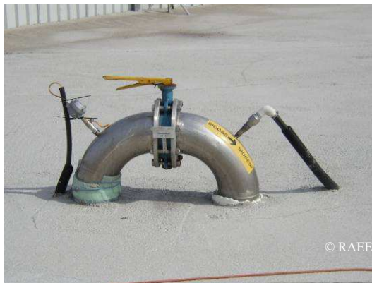
Canalisation biogaz
