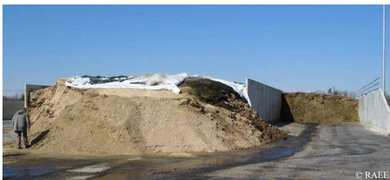
Zone de stockage de cultures énergétiques sous forme d'ensilage.
