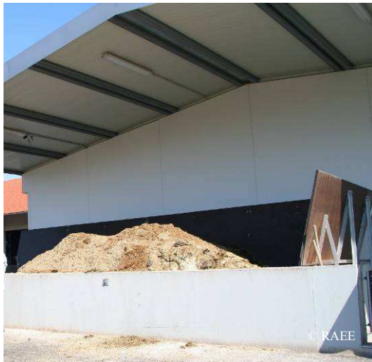
Alimentation d'un digesteur par du maïs ensilage en Autriche
