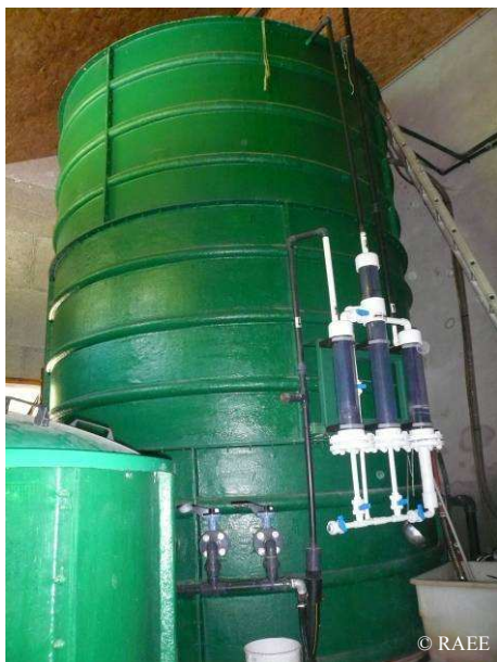
Le méthaniseur de l'Abbaye de Tamié, utilisant une technologie UASB
